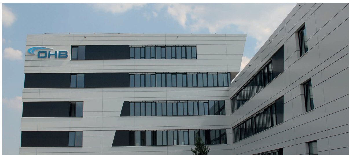
Newbuild of OHB System AG in Oberpfaffenhofen
