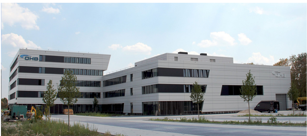
Newbuild of OHB System AG in Oberpfaffenhofen
