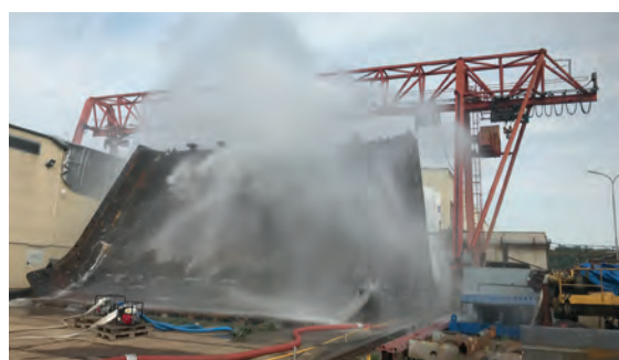
Deflektor beim Test eines Teilsystems der Wasserkühlung im Werk in Tschechien
